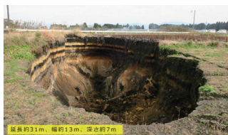
延長約31m、幅約13m、深さ約7m 都城・宮崎県の畑で起きた、豪雨によるシラス層の内部侵食による陥没（2016年9月）
