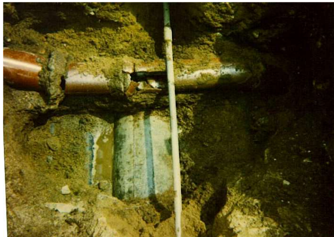
ガス管や水道管により破損した下水管
