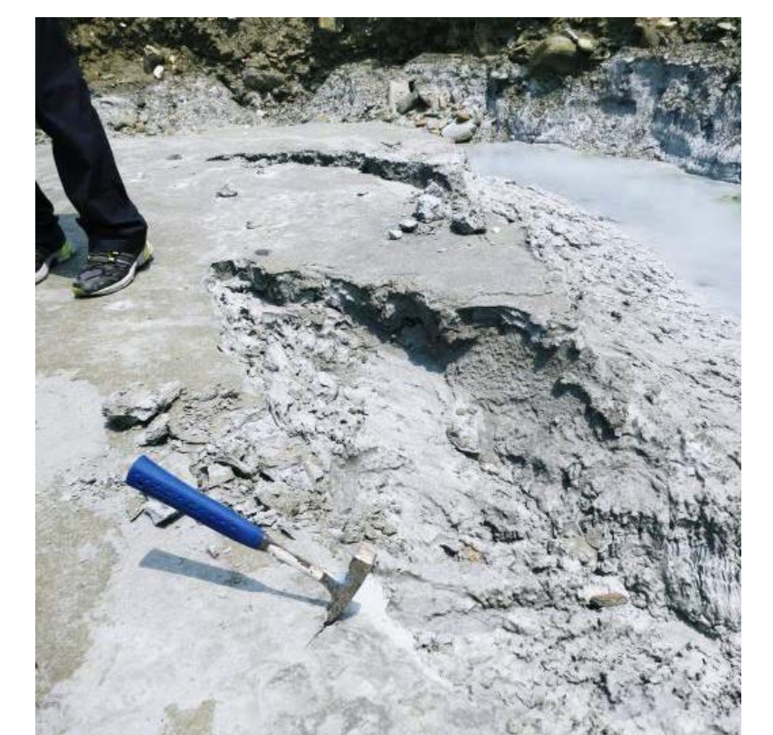
陥没孔底に堆積したシルト Soft clayey silt sediment in the bottom of sinkhole
