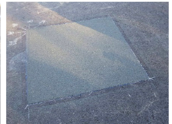
路面補強の外観
