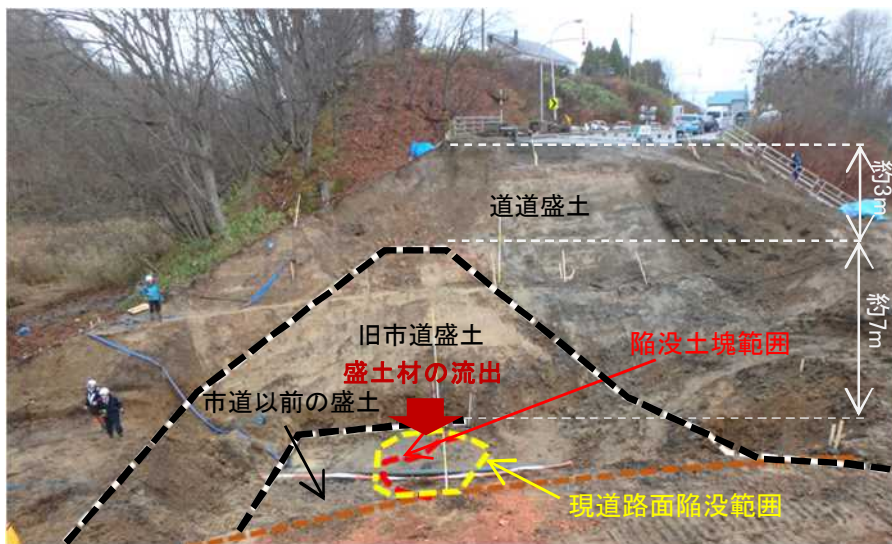
掘削全景（岩見沢側）
