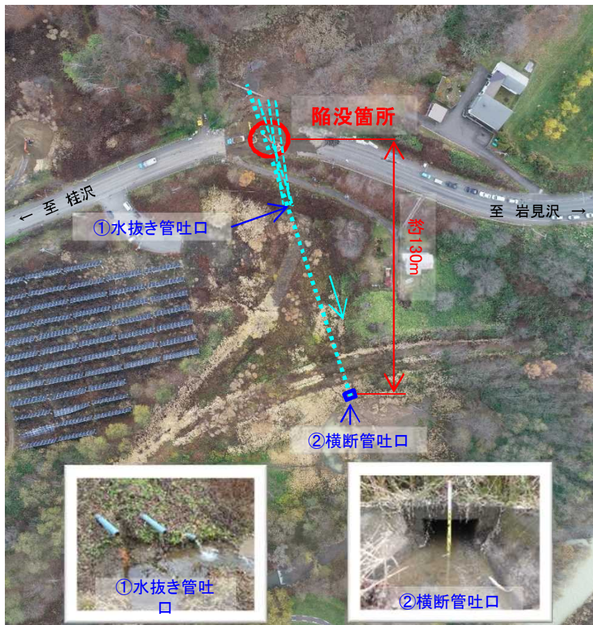
陥没箇所の全景（UAV撮影）
