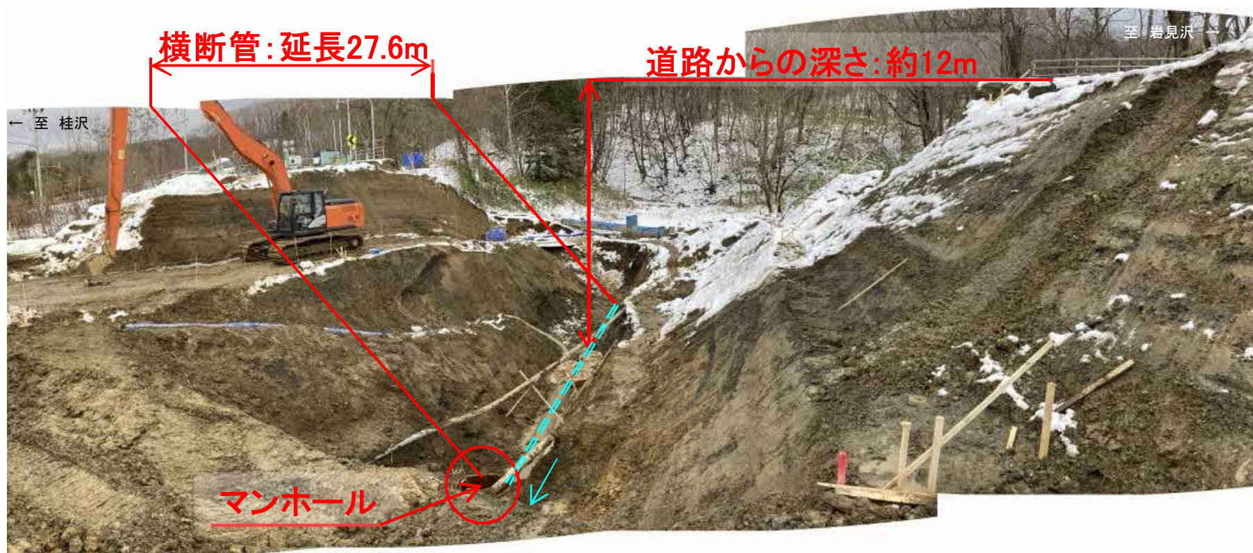
現地掘削（全景）
