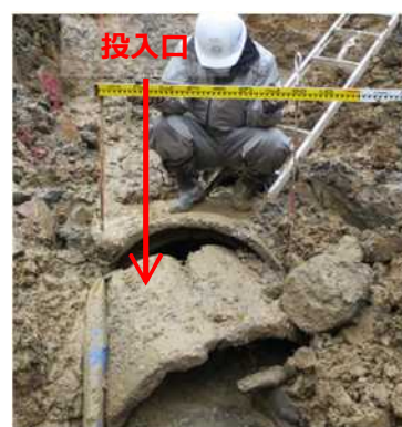
破損箇所から着色剤を投入
