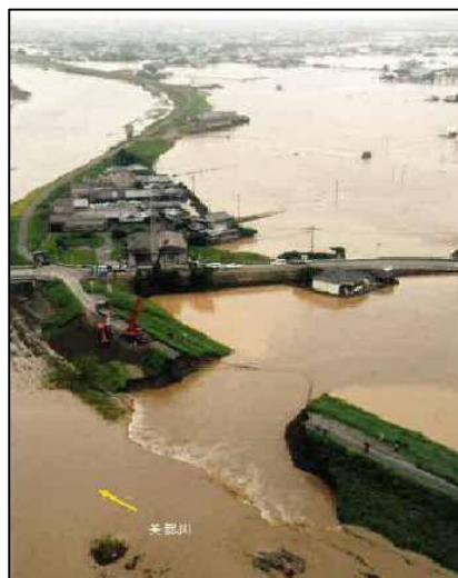
堤防決壊状況(矢部川:六合地区)
