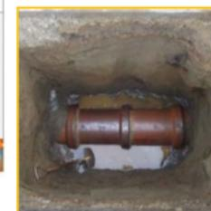
下水道管布設状況 S38施工
