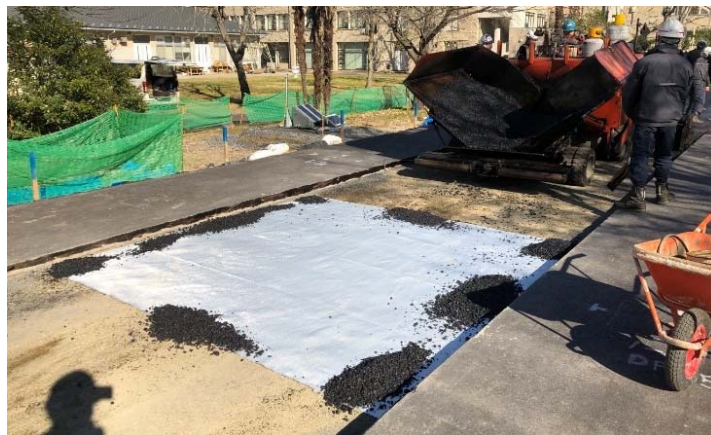
実物大試験道路における補強材（ジオテキスタイル）の敷設
